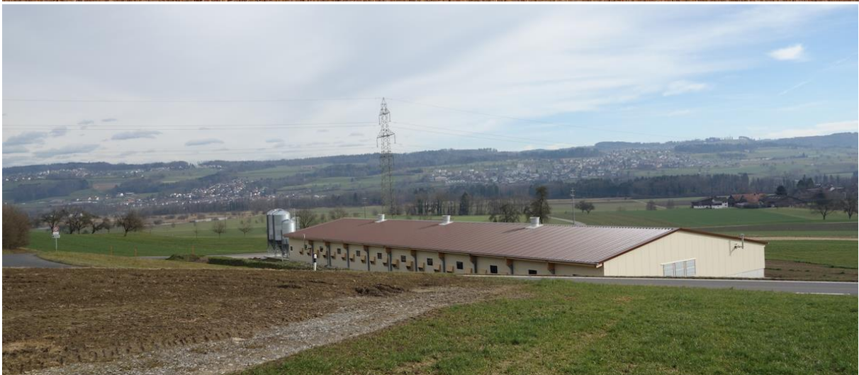
Trois exemples de nouvelles halles d'engraissement indépendantes du sol dans un rayon d'à peine quelques kilomètres dans le paysage non construit dans la vallée argovienne de la Reuss. L'une de ces halles a été construite en 2011 après un changement d'affectation, réalisé exceptionnellement pour les besoins du projet, d'une zone autrefois protection du paysage dans une zone agricole intensive.
