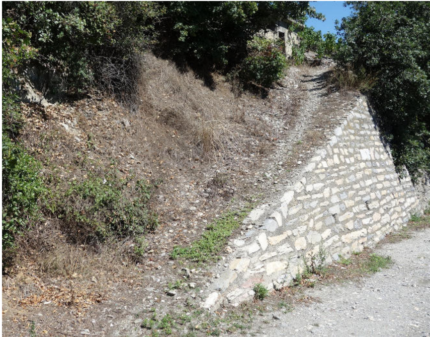
5 Verbreitete illegale Böschungspflege per Herbizid.
