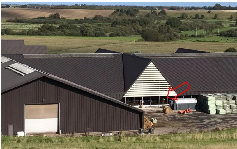
Exécution cohérente et sans failles : une caméra dans le réservoir qui peut être contrôlée directement par l'organisme de contrôle (devant le hangar moderne ouvert en bas à droite de l'image) documente si l'acide sulfurique prescrit pour la réduction de l'ammoniac est effectivement utilisé. Photo : Peter Maly
